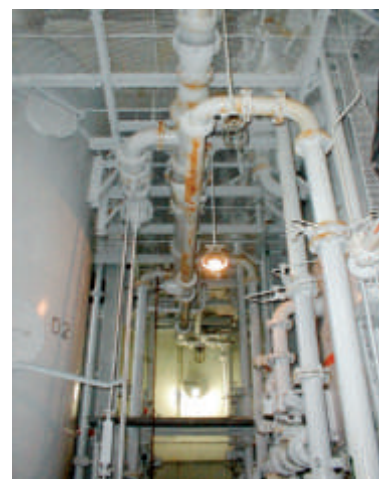
Ilustracija 7 Jakokiselni ionski filtri i deaeratori
