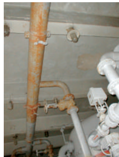
Ilustracija 6 Ulaz sirove vode u slabokiseli ionske filtre
