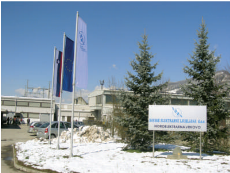
Ilustracija 10 Upravna zgrada HE Vrhovo
