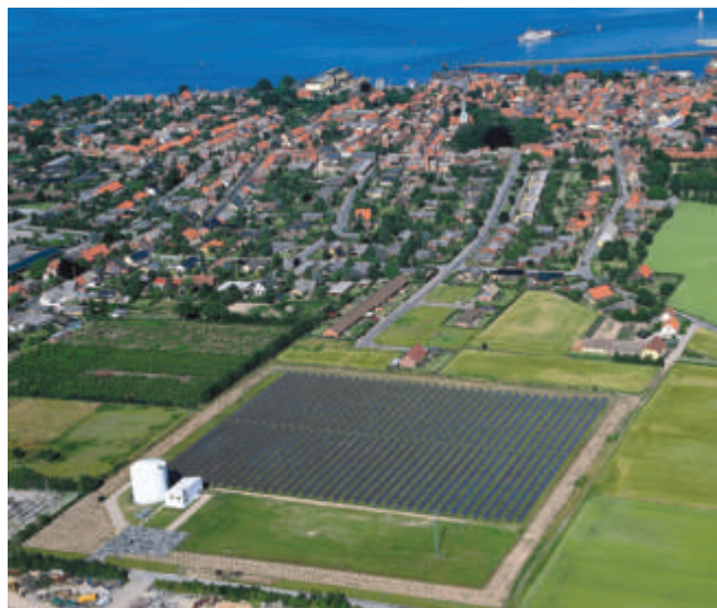
Ilustracija 2 Pogled na veliki solarni toplinski sustav u danskom gradiću Marstalu
