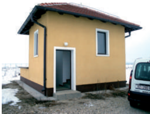
Ilustracija 3 Zdenac B3 vodocrpilišta Vinokovščak
