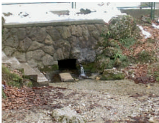
Ilustracija 5 Izvorište i sabirnica na izvorištu Belski dol
