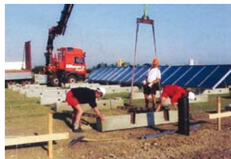
Ilustracija 3 Izvođenje radova na postavljanju novih kolektora u Marstalu
