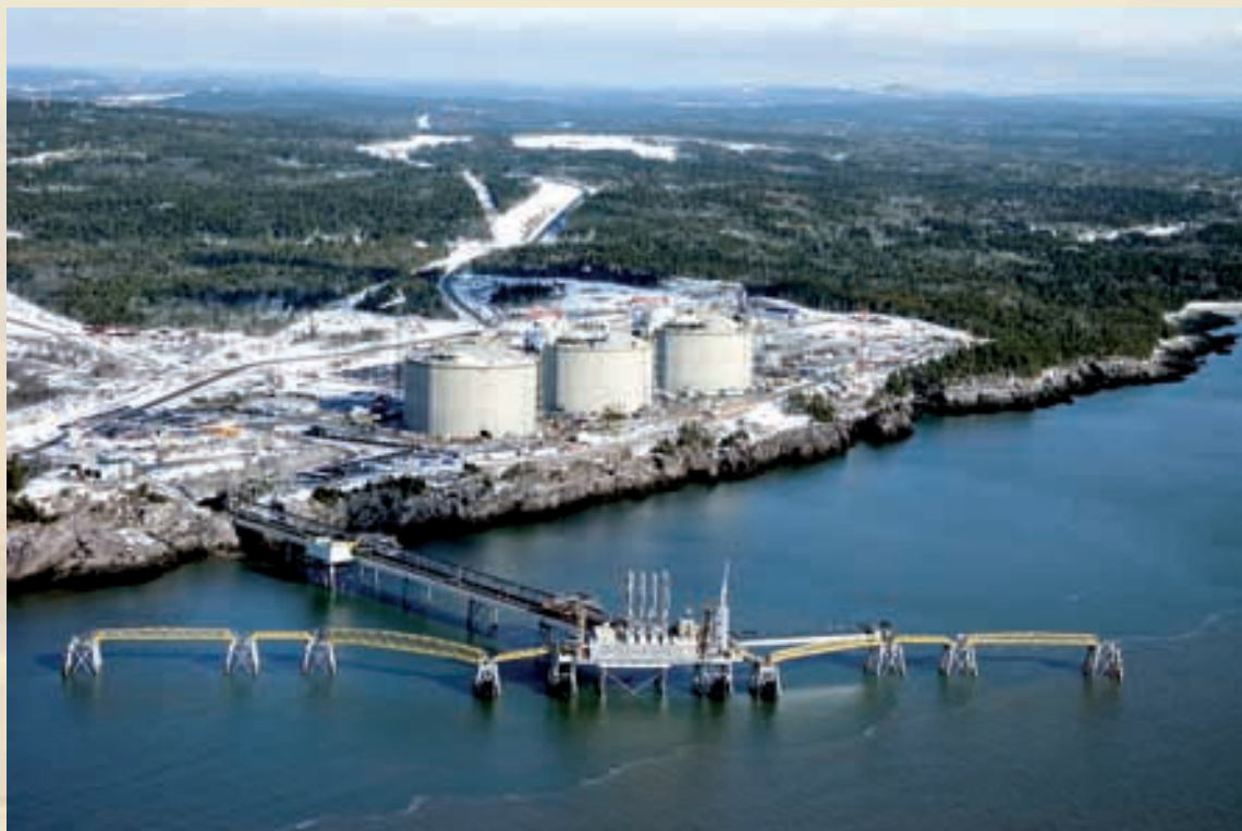
Ilustracija 4 Terminal za LNG
