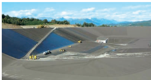
Ilustracija 4 Izrada nepropusnog asfaltnog sloja gornjeg jezera
