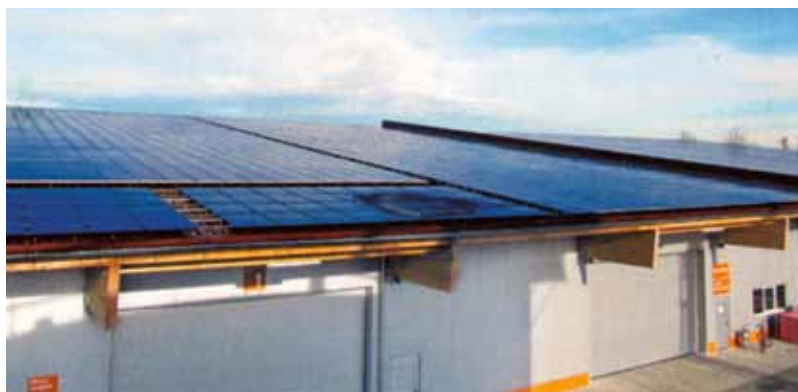
Ilustracija 7 Pogled na ispitno postrojenje s kombiniranim kolektorima na krovu proizvodnih pogona tvrtke Solarzentrum Allgäu u Njemačkoj
