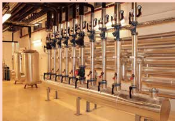
Nove instalacije sustava grijanja u Bolnici Rebro
