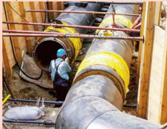
Detalj revitalizacije vrelovodne mreže
