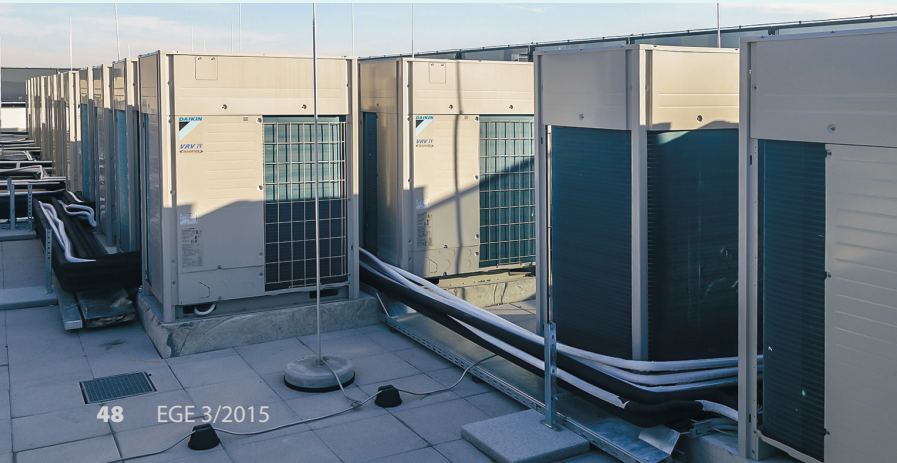
Sve vanjske jedinice smještene su na krovu objekta, na 26 etaži, a unutarnje tipa FXZQ-A (jedinstvena potpuno ravna kazetna jedinica) i FXFQ-A (jedinstvena kružna kazetna jedinica) i prateći razvod cijevi u podstrupu po etažama
