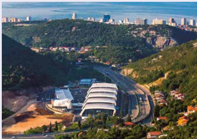
◀ Impresivan kompleks Pharma Valley uz autocestu A6
