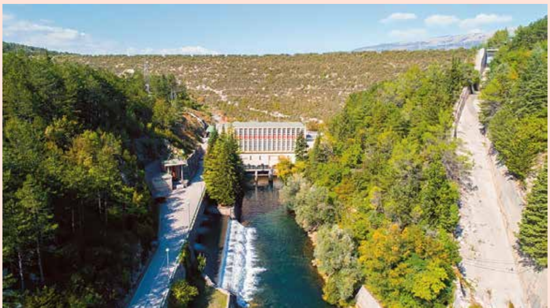
► Zgrada strojarnice u podnožju brane
