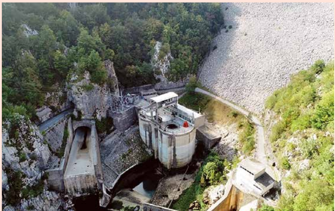
► Strojarnica i ispušt pri dnu brane
