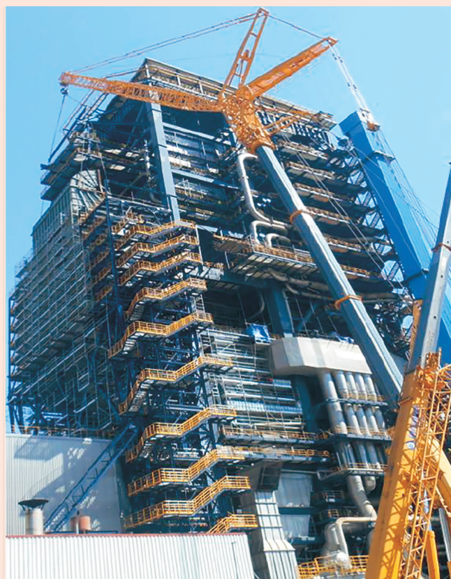
▲ Izgradnja DeNO x postrojenja
